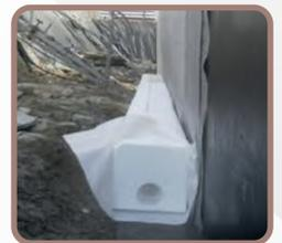
Léger, maniable, Cunette intégrée, 1,20m<sup>2</sup> de capacité de captage
